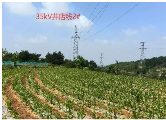
跨越 35kV 井店线 2#~3#档
