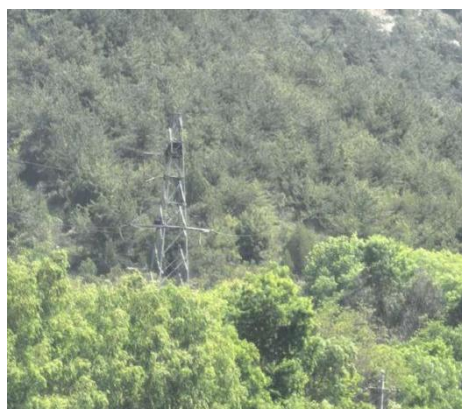
穿越 35kV 井店线 12#~13#档
