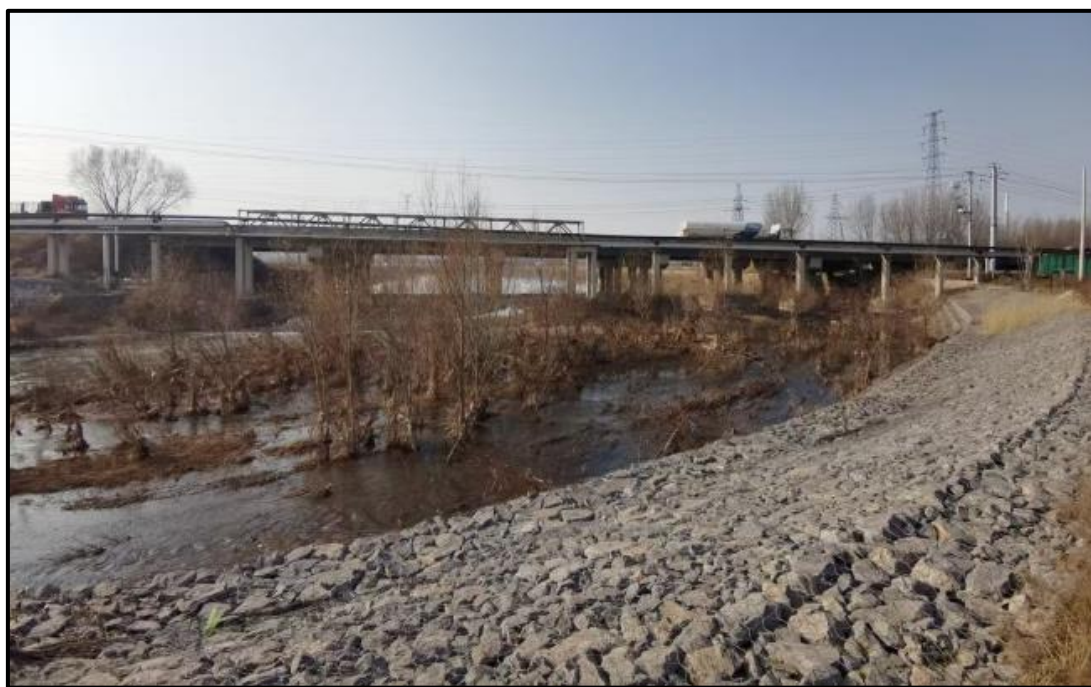
图 3-1 南坡大桥照片
