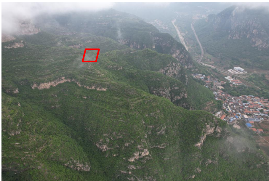
塔基及塔基施工区
