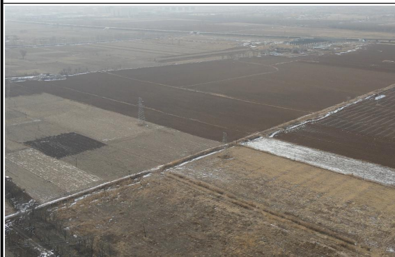
塔基及施工区
