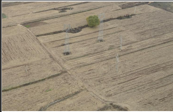
塔基及施工区
