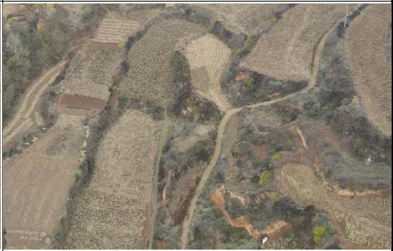
塔基及施工区
