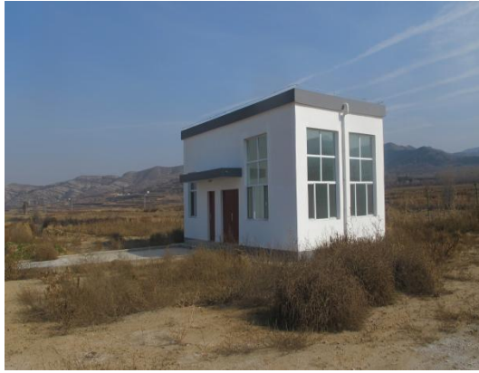
项目填埋气抽气机房
