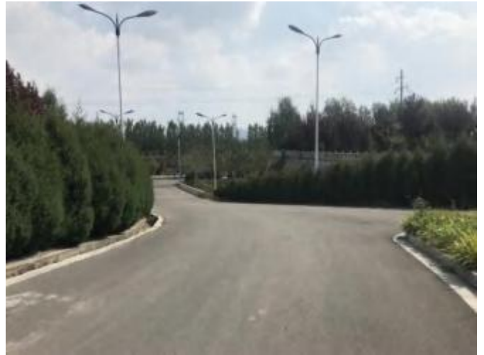
厂区外运输道路
