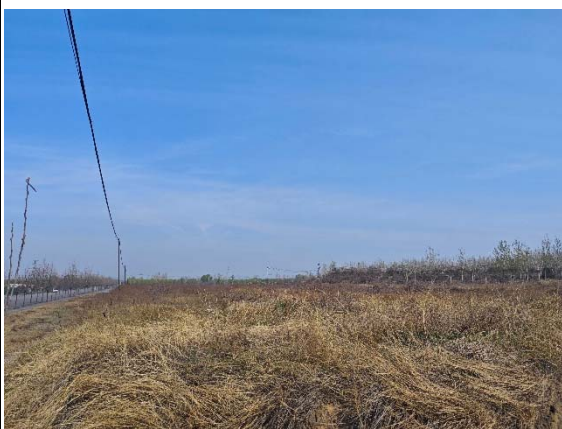
塔基及施工区（占用其他草地区域）
