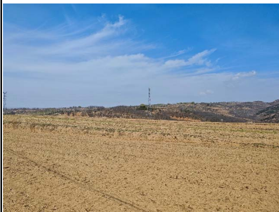
塔基及施工区（占用旱地区域）
