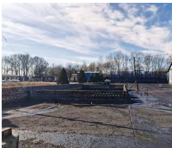
水土保持措施现状照片（盖板排水沟、雨水收集池）
