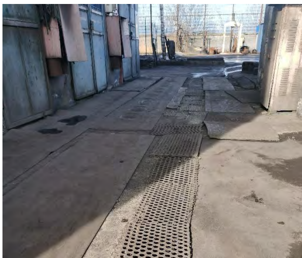
水土保持措施现状照片（盖板排水沟、雨水收集池）
