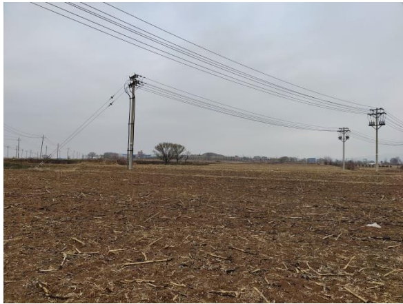
塔基及施工区
