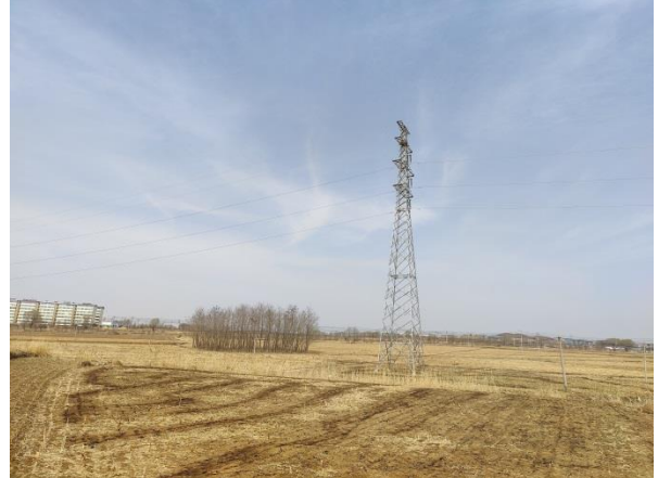
塔基及施工区
